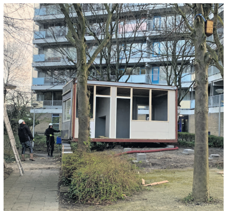
Drie kantoorunits werden met een grote hijskraan geplaatst op de vroege donderdagochtend.
